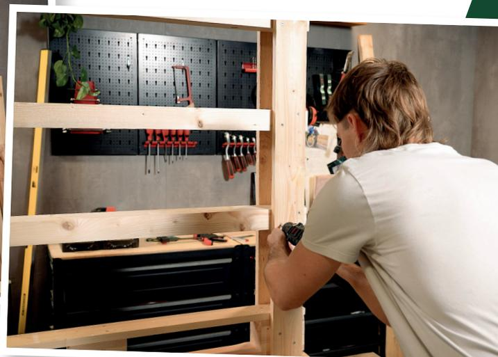
Nun werden die Querbalken (F) gleichmäßig von oben nach unten zwischen die Schalbretter (D + E) eingesetzt. Zum Festschrauben kannst du ebenfalls 4,5x60 mm Senkkopfschrauben verwenden.
